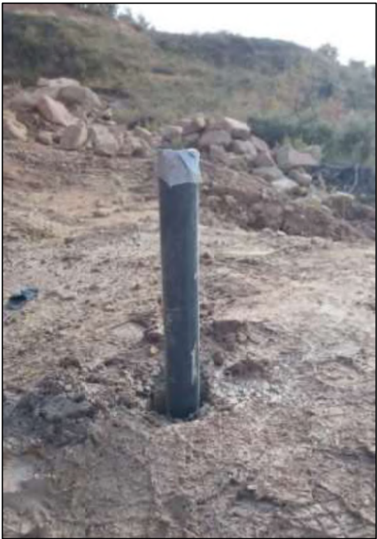
Fotografia 16. Tub de PVC instal·lat en la perforació.
