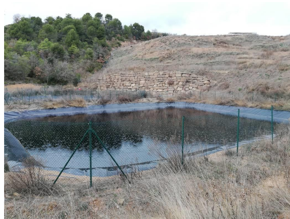
Bassa de lixiviats i mur de contenció d'escullera vas fase 0 clausurada (09/02/2021).
