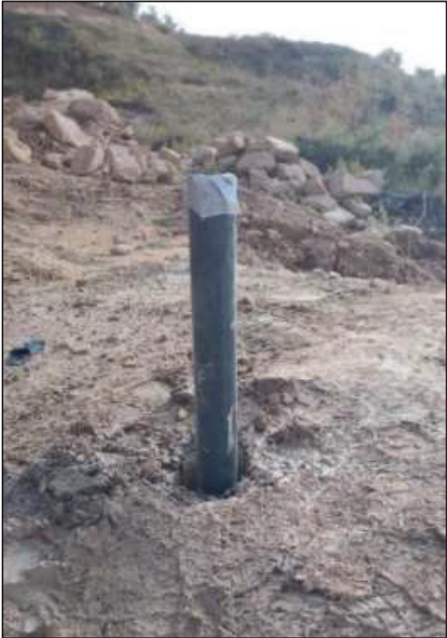
Fotografia 16. Tub de PVC instal·lat en la perforació.
